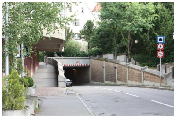
Foto 22: Broner Platz - Tunnel
